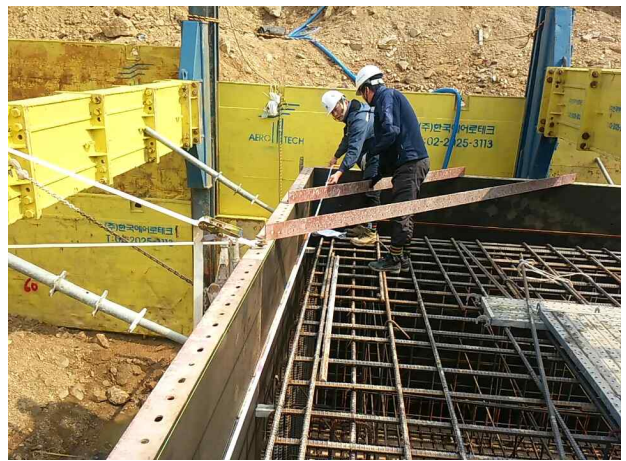
P5(영천방향) 기초 단면 폭 측정
