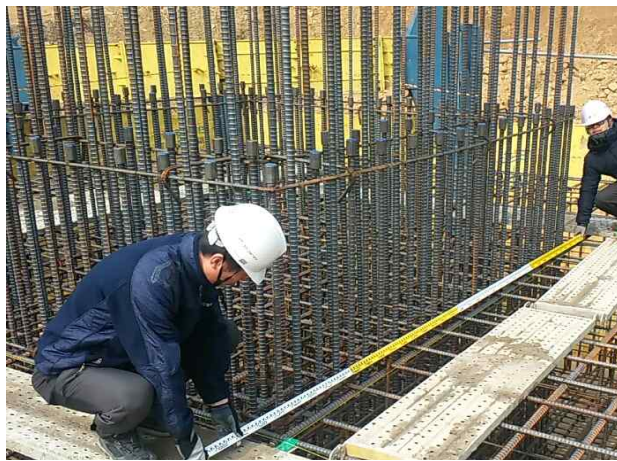
P5(상주방향) 기초 상면 철근 간격측정
